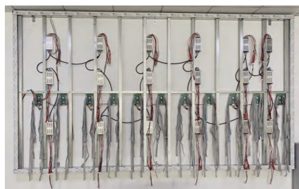
01 Lắp đặt khung và nguồn điện
